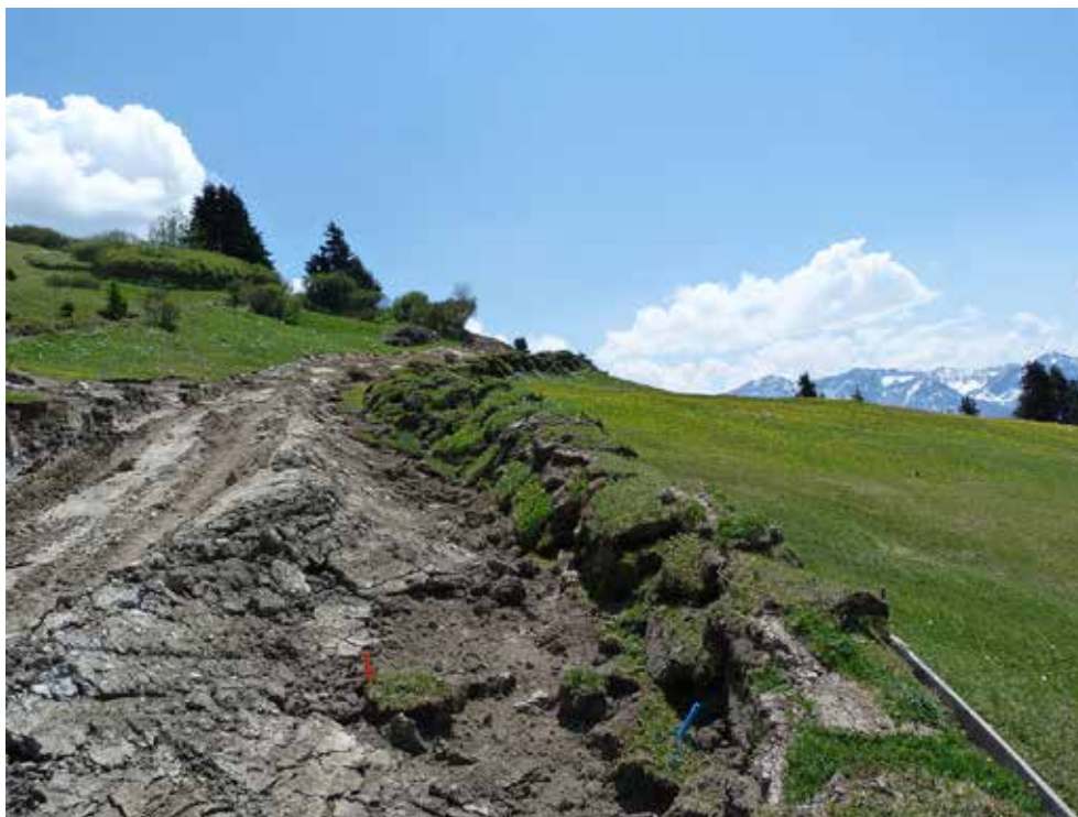
Les plaques de gazon sont entreposées tout le long du chemin, réparties dans la zone de pivotement de la machine d'excavation.
