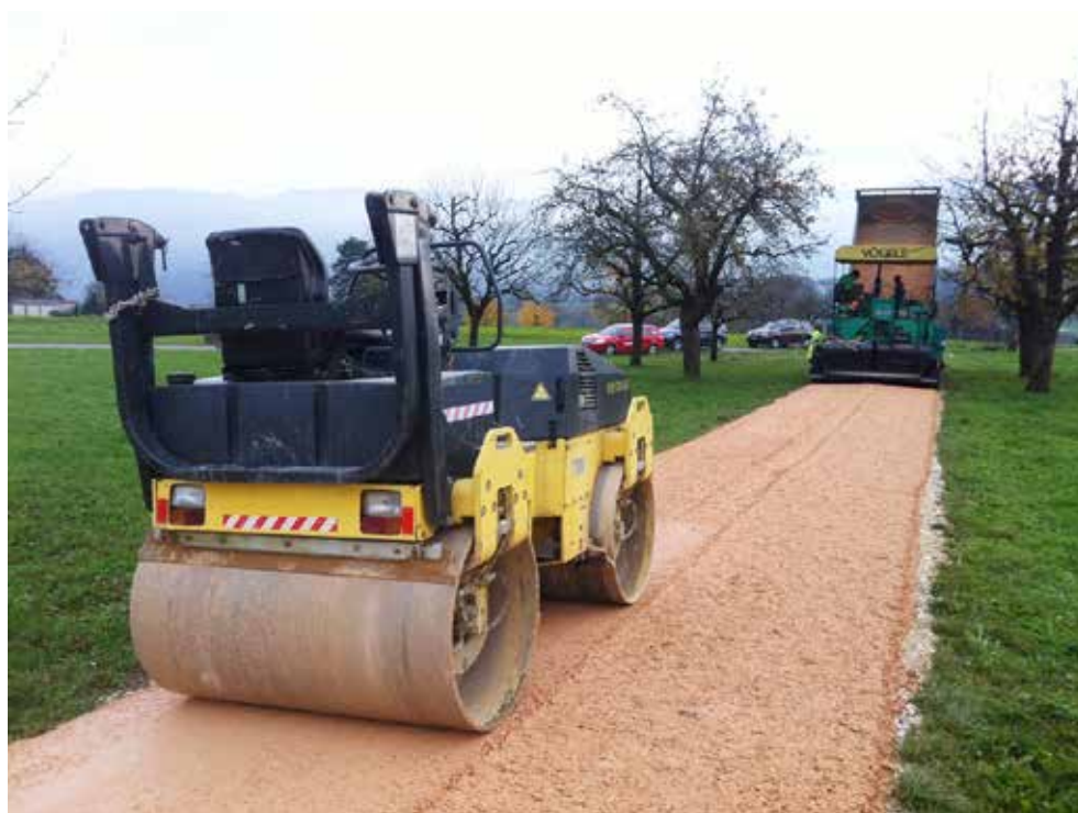
Construction d'un chemin dans le cadre de l'amélioration foncière intégrale de Blauen.
