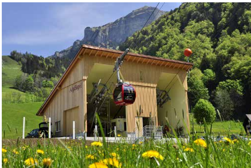
Station inférieure du nouveau téléphérique Sigel.
